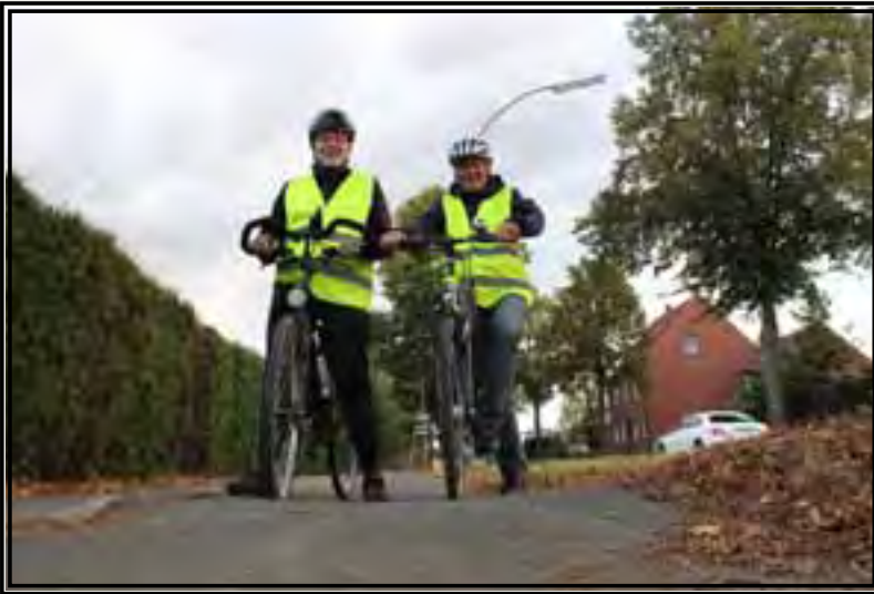
Radweg als Buckelpiste an der Wareндorfer Straße in Oelde. Matthias Rempe und Tourenleiter Konrad Baining (v. l.). Bild: Fabian Reinkemeier
