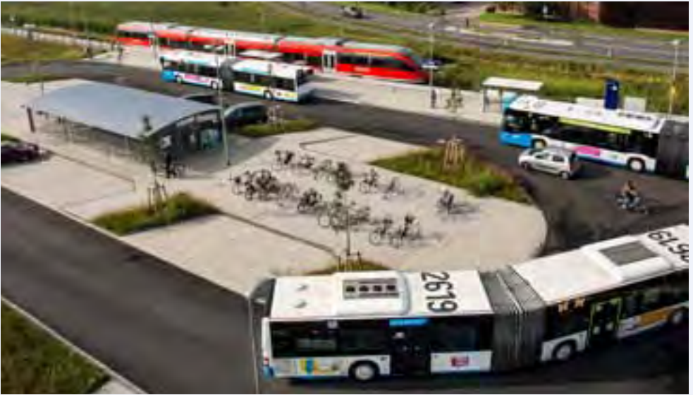
Als „Mobilstation Bahnhof Roxel“ wurde eine Buswende mit integrierter Park+Ride-Anlage konzipiert und gebaut. Insgesamt stehen dort 27 Pkw-Stellplätze und 130 Stellplätze für Fahrräder, davon 58 überdachte in der „Leezenbox“ zur Verfügung. Diese verfügt über eine moderne elektronische Schließanlage, die mit eTicket des ÖPNV kompatibel ist. Die „Leezenbox“, betrieben durch die Stadtwerke Münster, dient als Prototyp für vergleichbare Bahnhöfe und Haltepunkte im Stadtgebiet. Bild: 3. NVP Münster
