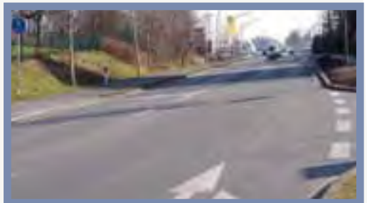
Linksseitiger Zweirichtungsrad-/fußweg in Altenberge: Gefahren und Behinderungen für Radfahrer und Fußgänger
