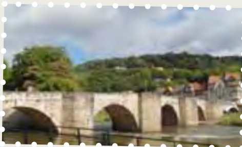
Brücke über die Werra bei Hannoversch Münden
