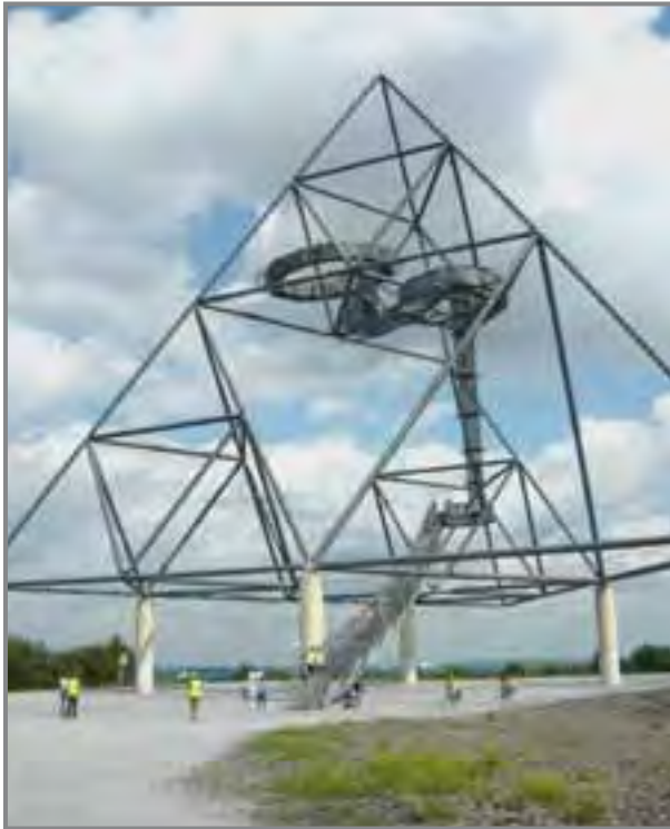
Aufstieg auf die 90 Meter hohe Halde zum Tetraeder geschafft
