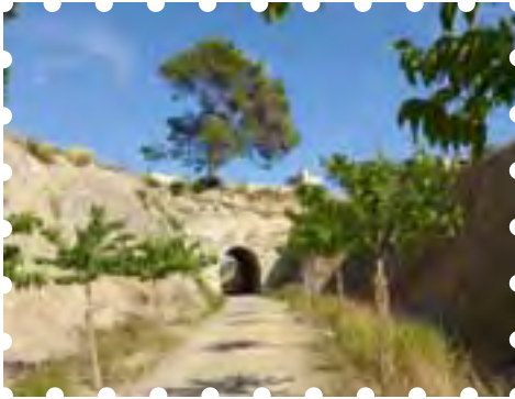
Tunnel bei Sant Llorenç des Cardassar
