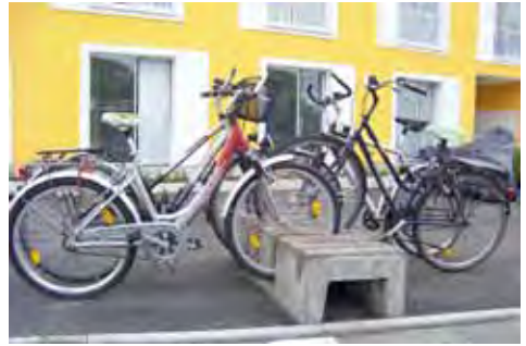
Untaugliche Abstellanlage, weil nicht diebstahlsicher
